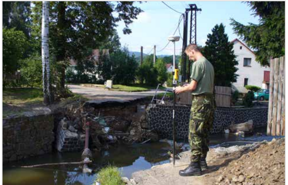
Obr. 12 Zaměření prostoru jednoho z poškozených mostů po ničivé povodni v roce 2010
