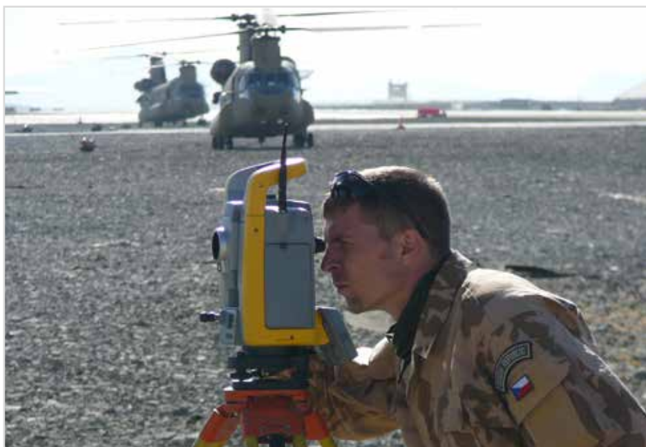
Obr. 14 Měřické práce na letišti vrtulníků na základně Šarana
