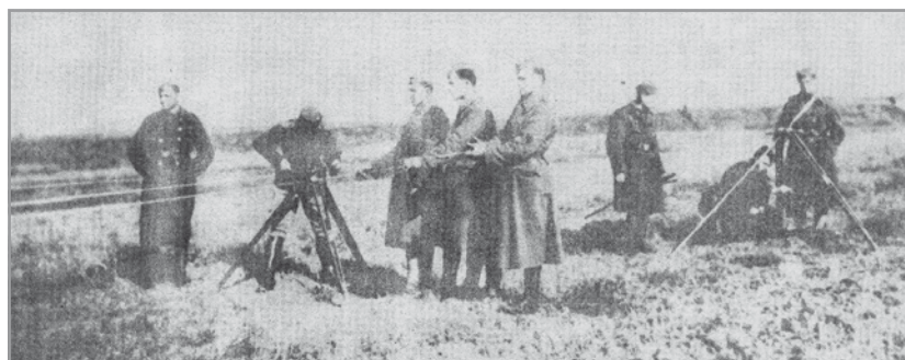
▲ Dobový snímek z měření základny u Feledinců invarovými dráty
