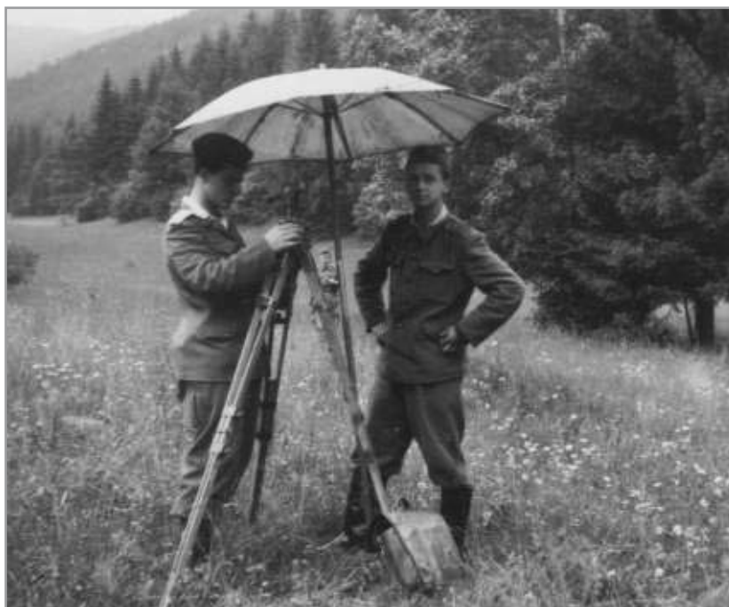
Obr. 8 Příprava k měření – urovnávání teodolitu
