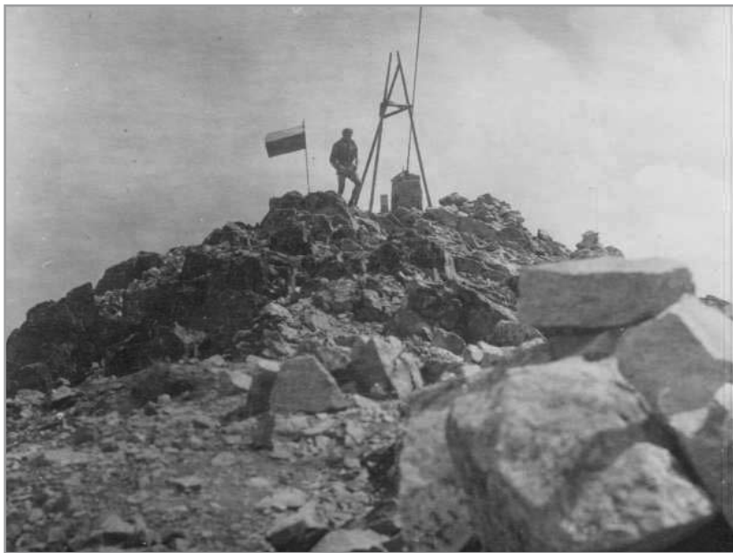
Obr. 5 Stavba tyčového signálu na Kriváni ve výšce 2 494 m
