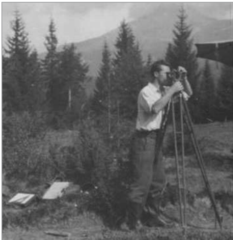
Obr. 10 Měření vřícovacích bodů v Západních Tatrách pro celostátní mapování v měřítku 1 : 25 000
