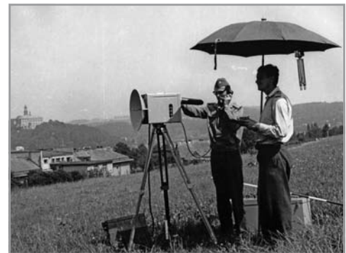
▲ Měření radiovým dálkoměrem GET B1
