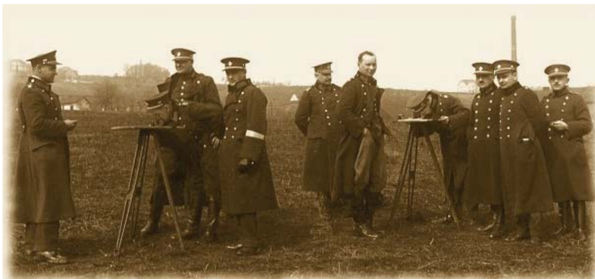
Odborná příprava budoucích topografů VZÚ v terénu na dobovém snímku
