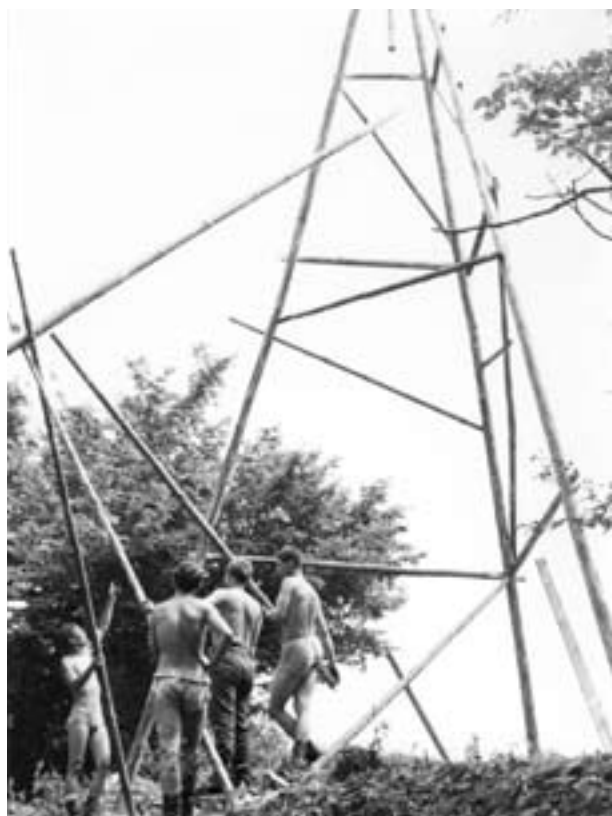
Obr. 7 Rozestavěná triangulační věž
