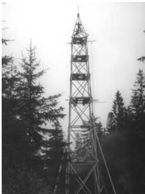
Obr. 8 Triangulační věž těsně před dokončením
