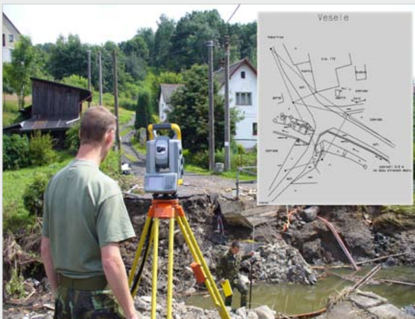
▲ Pprap. Vít Rozum (měřič) a npor. Ing. Viktor Pecina při provádění geodetických prací při přípravě výstavby mostních provizorií po povodních v r. 2009 v obci Veselé a výsledný geometrický plán.
