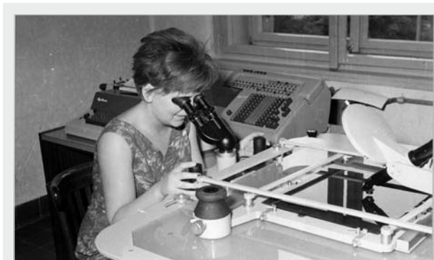
▲ Univerzální stereofotogrammetrické vyhodnocovací přístroje Stereoplanigraf C-5 firmy Zeiss tvořily základní vybavení fotogrammetrického odboru při novém mapování státu.
