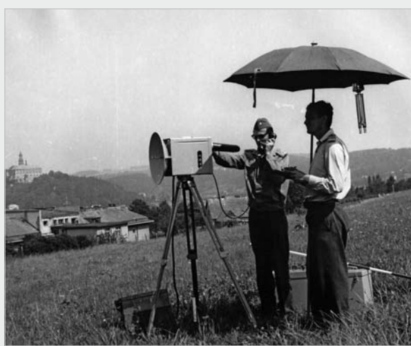
▲ Měření s radiovým dálkoměrem GET-B1.
