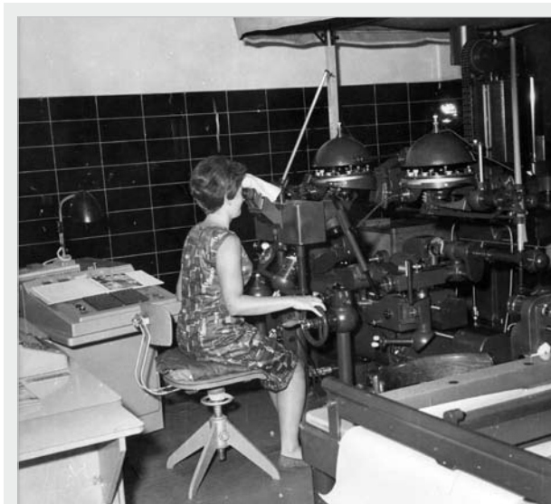
▲ Univerzální stereofotogrammetrické vyhodnocovací přístroje Stereoplanigraf C-5 firmy Zeiss tvořily základní vybavení fotogrammetrického odboru při novém mapování státu.
