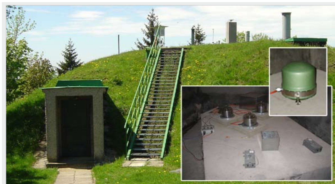
▲ Seizmometr STS-2 (zelený kryt) s dalšími seizmickými čidly na betonovém pilíři v bunkru na stanici Polom.
