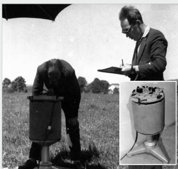
▲ Měření gravimetrem ASKANIA Gs12.
