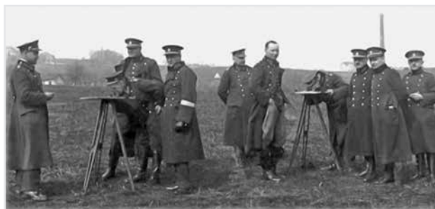
Odborná příprava budoucích topografů VZÚ v měření metodou stolové tachymetrie
