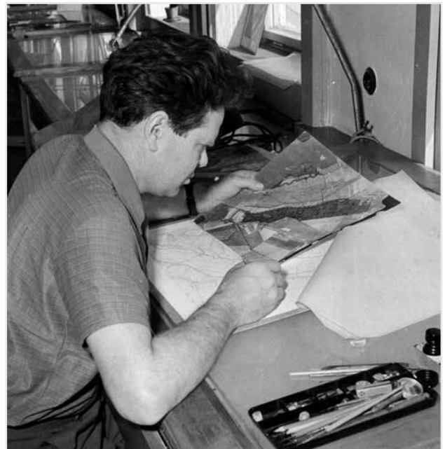
Kresba topografického originálu na kresličském oddělení VTOPÚ s využitím leteckého snímku jako revizního podkladu
