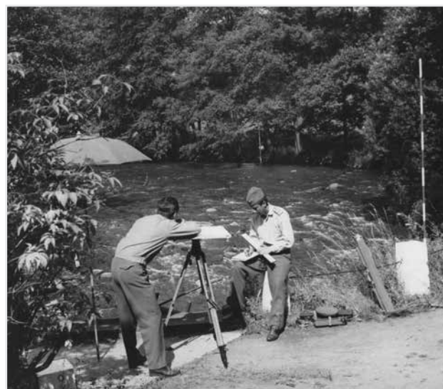
Mapovací práce prováděné metodou stolové tachymetrie
