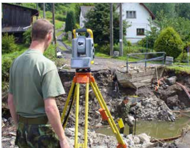
Měřické práce při výstavbě mostních provizorií
